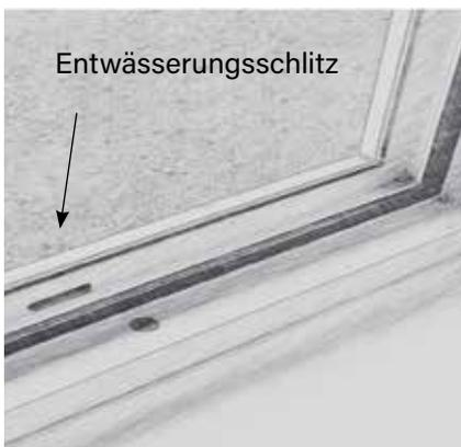
Damit Wasser, das etwa bei starkem Schlagregen oder beim Fenster in Kippstellung in den Rahmenfalz eindringen kann, direkt wieder abgeleitet wird, hat jedes Fenster sogenannte Entwässerungsschlitze. Diese finden Sie bei geöffnetem Fenster z. B. innen im Rahmenfalz. Kontrollieren Sie diese regelmässig, etwa beim Fensterputzen, und entfernen Sie eventuelle Verstopfungen.
