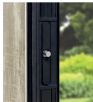
Dreidimensional verstellbares Schließteil im Türflügel
