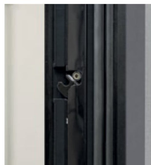
Der Verschluss mit pferdekopfförmiger Verriegelung im Rahmen
